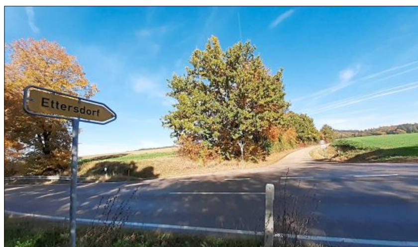
Die Straße nach Ettersdorf soll im kommenden Jahr ausgebaut werden, dabei wird auch eine neue Wasserleitung verlegt. Foto: Sandra Meilinger
