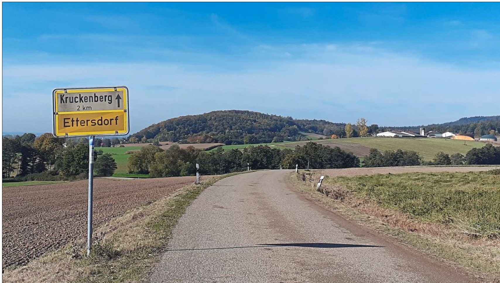
Unter die dann sanierte und ausgebauten Gemeindeverbindungsstraße von Ettersdorf zur Staatsstraße 2125 wird gleich eine neue Wasserleitung verlegt. Gut 930000 Euro an Brutto-Baukosten sind veranschlagt.
