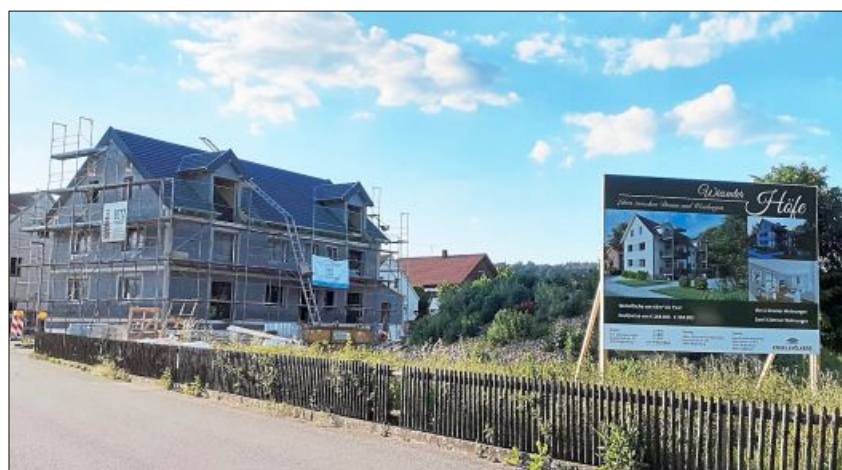
Die Gemeinde Wiesent besteht beim Bauvorhaben am ehemaligen Spitzer-Anwesen auf genügend Stellplätze. Dass Duplex-Parkmöglichkeiten ideal sind, bezweifelt der Gemeinderat. Foto: Meilinger
