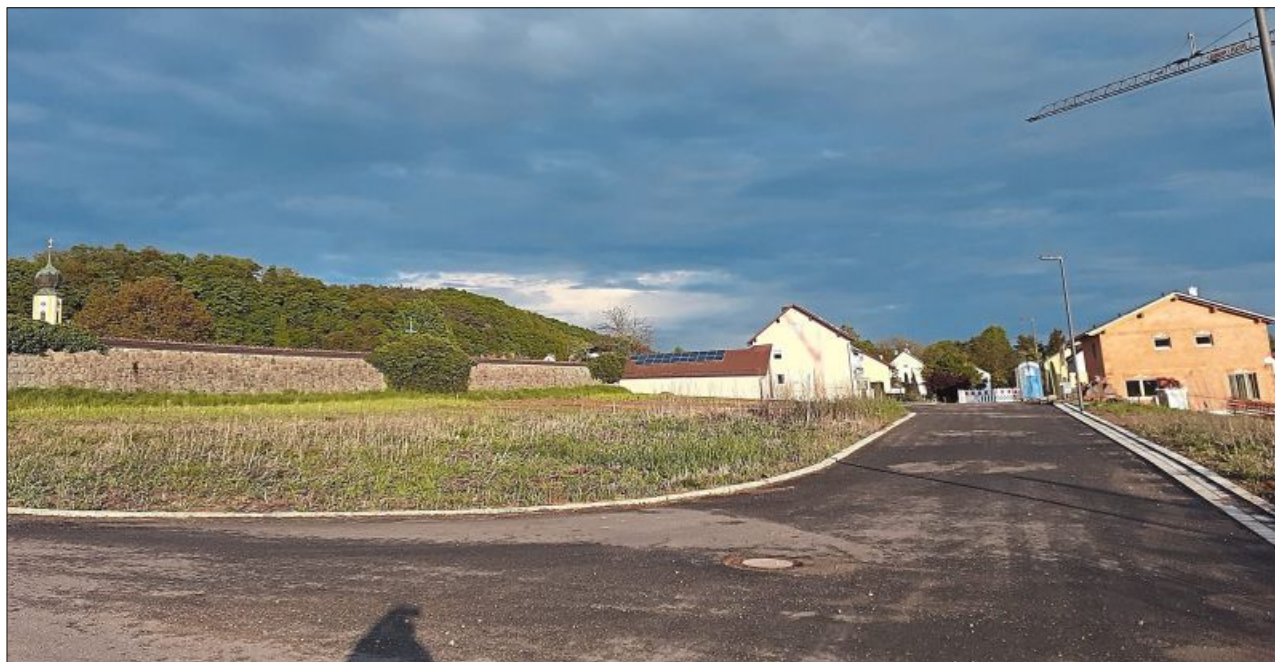
Im Baugebiet Wiesent Mitte/Moosackerweg entsteht durch die Aumer GbR ein Mehrfamilienhaus mit Tiefgarage (links auf dem freien Gelände). Die Vergabe hierfür erfolgte im Rahmen einer Konzeptausschreibung durch die Gemeinde, die einen familienfreundlichen Wohnmix und Barrierefreiheit beinhaltet. Foto: Meilinger
