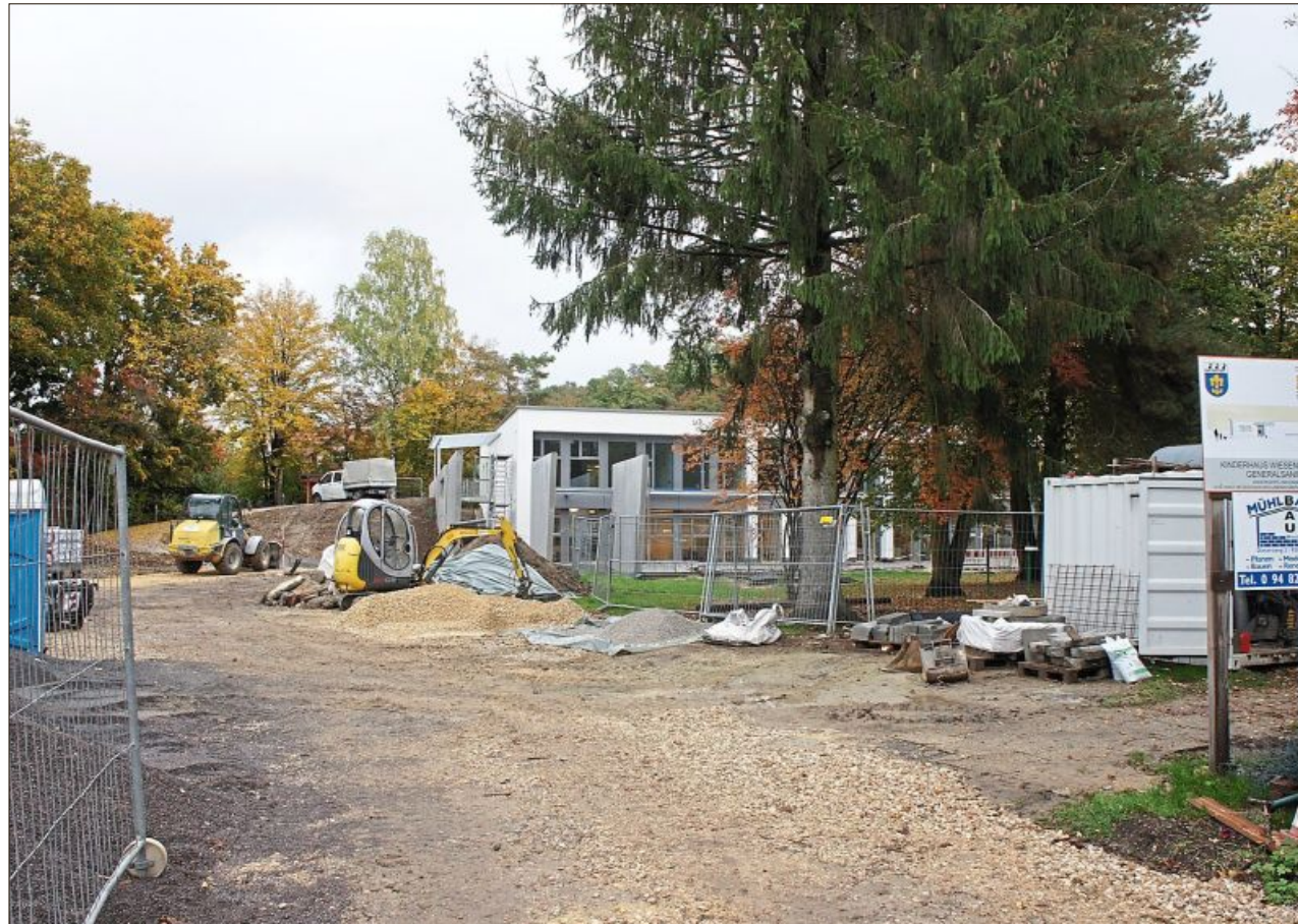
Die Arbeiten am Kinderhaus gehen planmäßig über die Bühne. Dem Einzug aller Gruppen des Kindergartens und der Krippe im Januar steht nichts im Weg.
