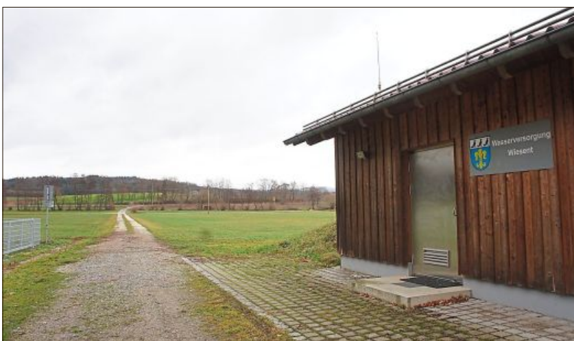
Eine Photovoltaikanlage auf dem Gelände der Wasserversorgungsanlage Ammerlohe soll den Strom für die Pumpen produzieren.
