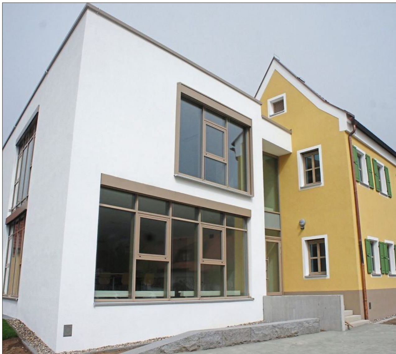
Bei der Gestaltung des neuen Rathauses wurde auf eine gute Außendämmung Wert gelegt. Der Wärmebedarf konnte so deutlich gesenkt werden, um dem Ziel eines „klimaneutralen Rathauses“ näher zu kommen. Archivfoto: Meilinger
