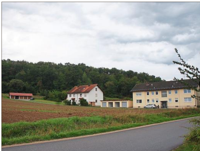
Die Niederschlagsbeseitigung bei der Petersberger Straße stellt mit und ohne Baugebiet ein Problem dar und muss aufgrund wasserrechtlicher Belange gelöst werden. Foto: Meilinger
