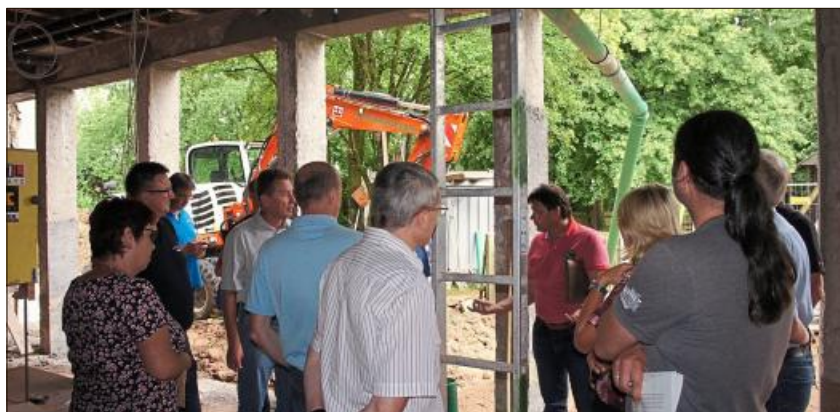
Die Gemeinderäte machten sich ein Bild vom Stand der Baumaßnahmen am Kinderhaus.
