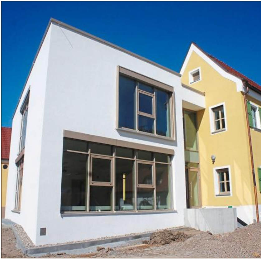
Im Anbau des Rathauses wurde ein neuer Sitzungssaal geschaffen, der auch als Trauzimmer dient. Mit Investitionen wie dieser ist Wiesent offiziell auf einem guten Weg, bestätigt die Rechtsaufsicht des Landkreises.
