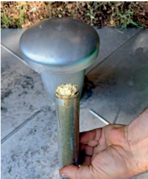
Foto: Fettablagerung an einer Sonde in der Pumpstation
