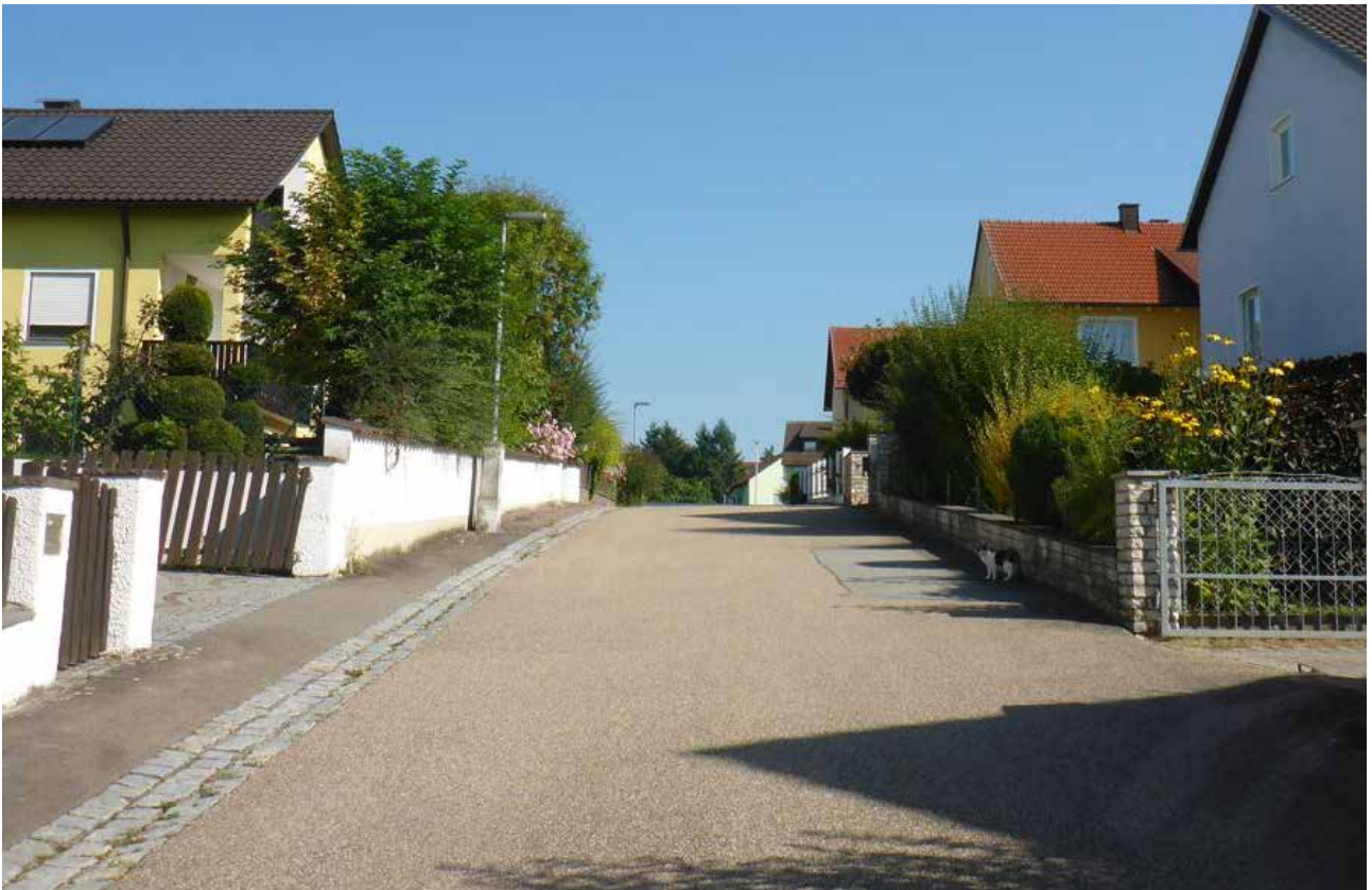
Abb.: Einseitiger Gehweg, geringer Barrierefreiheitsgrad aufgrund von Rinne und Gehwegsbreite (Quelle: STADTENTWICKLER)
