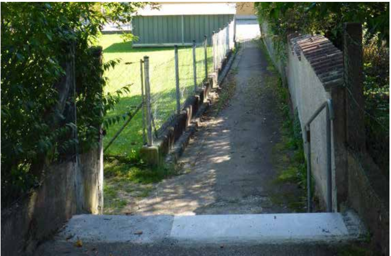
Abb.: Fehlende Barrierefreiheit: Treppe zur Überwindung der Höhenunterschiede (Quelle: STADTENTWICKLER)
