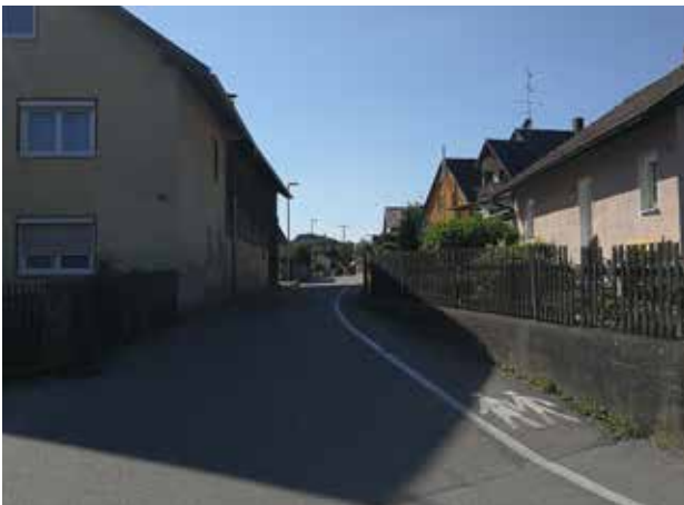
Unsicherer Schulweg durch fehlenden Gehsteig im Ettersdorfer Weg
