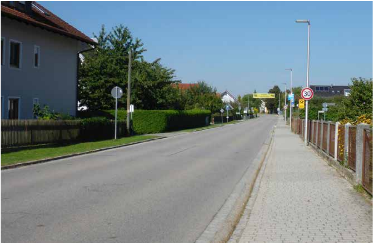
Abb.: Einseitiger Gehweg, z. T. fehlende Bordsteinabsenkung zur Querung der Straße (Quelle: STADTENTWICKLER)
