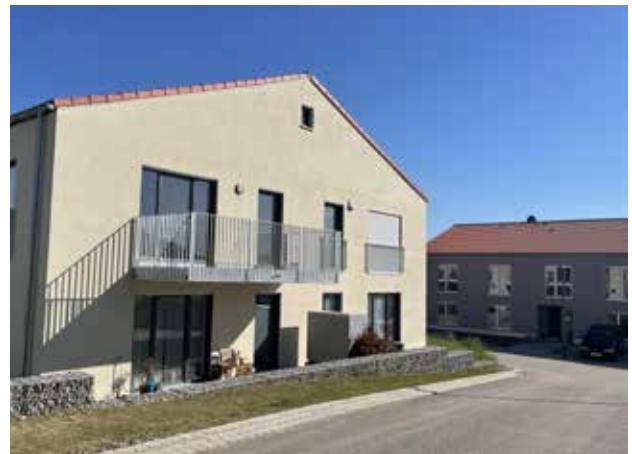
Neu entstandenes Mehrfamilienhaus (vorne), neu entstandener sozialer Wohnungsbau (hinten)
