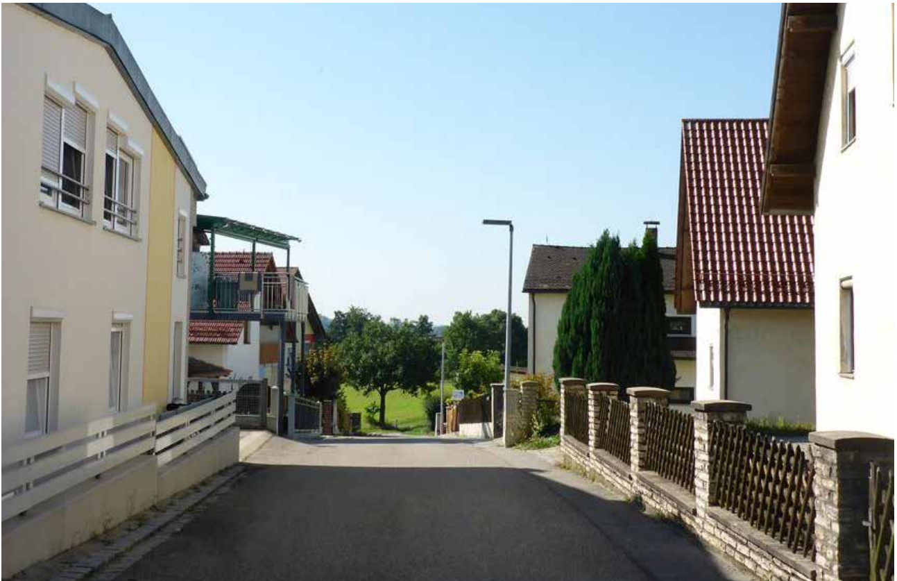
Abb.: Keine Gehwege: sinnvoll bei schmalen, verkehrsberuhigten Straßen, Barrierefreiheit sichergestellt (Quelle: STADTENTWICKLER)
