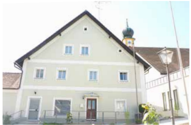
Saniert und in gutem Zustand
